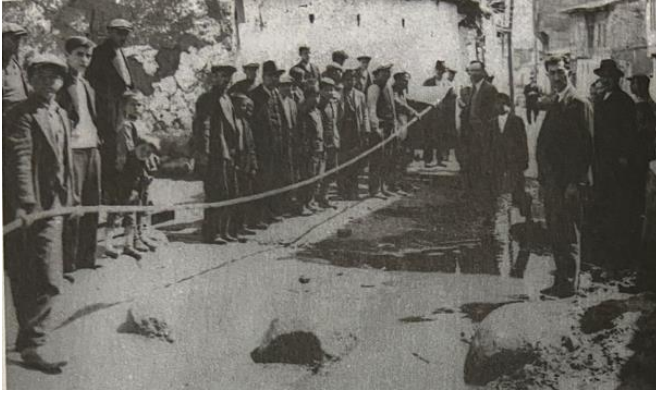
1939 yılında Yeraltı Elektrik Kablolarının Döşenmesi
